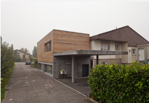
Angedockt Erweiterungsbau in Kappelen, 2009
