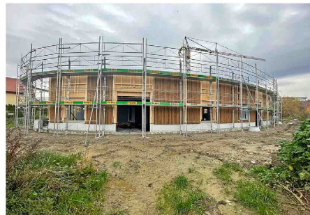
Der aktuelle Stand der Bauarbeiten.
